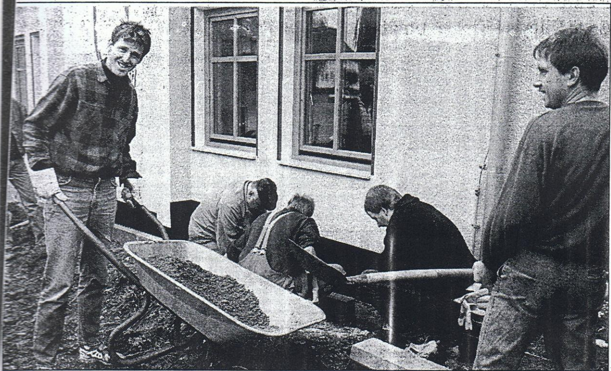
Setzen die Bordsteine: die Feuerwehrleute aus Rüchenbach, der Partnerwehr Udenhausens.
