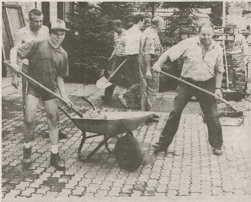
Stein auf Stein, das Häuschen wird bald fertig sein: Mit Hilfe der Udenhäuser Partnerwehr gingen die Arbeiten am Feuerwehrgerätehaus zügig voran.
