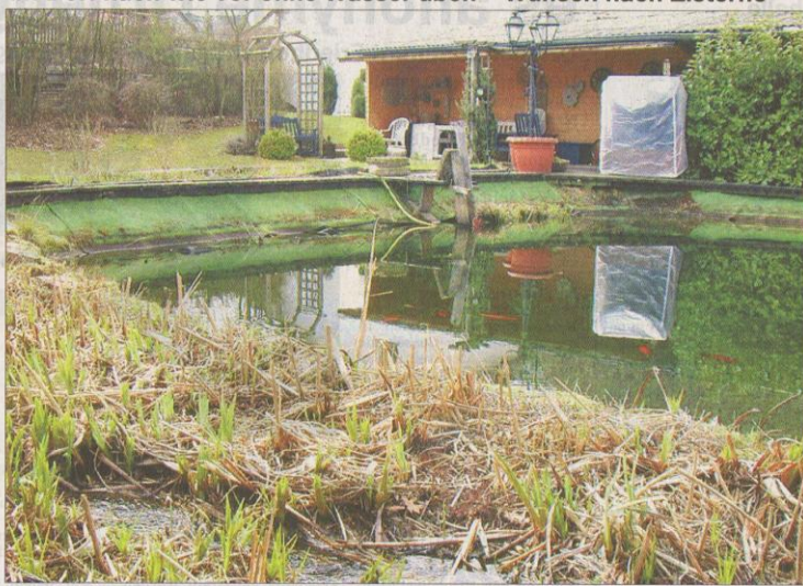
Der Löschteich der Firma Richter in Rüchenbach kann begrenzt als Löschteich genutzt werden. Diese Möglichkeit ersparte der Stadt den Bau einer Zisterne.
